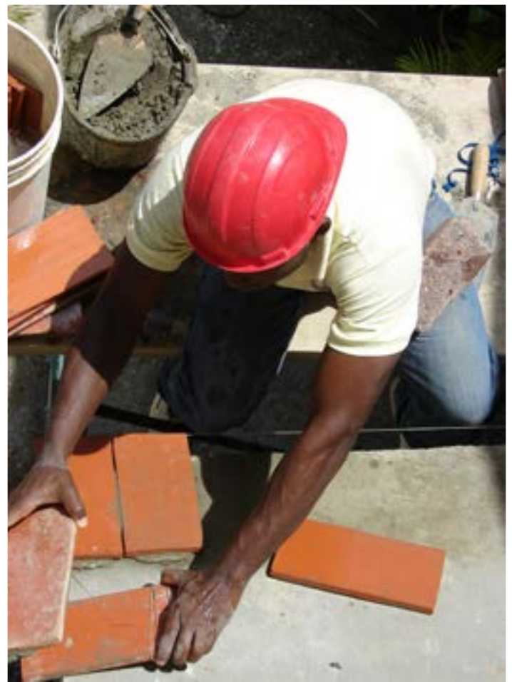
Intervención.- Colocación de losas barro en toldos en área oficina
