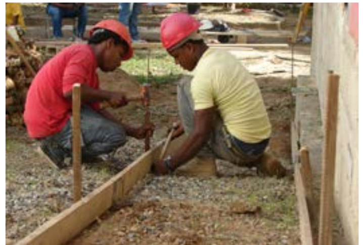
Práctica.- Nivelación, replanteo y trazado en obras
