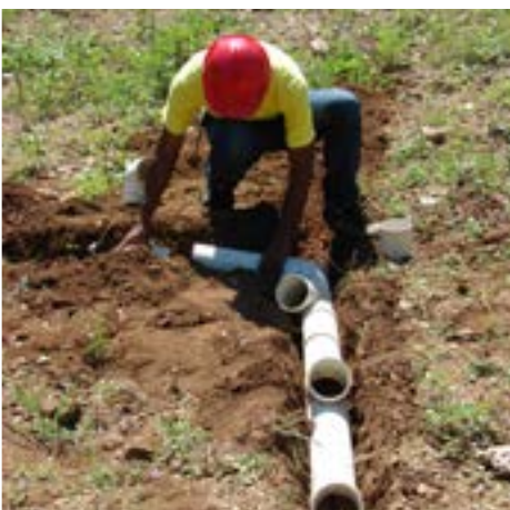
Práctica: Instalación de sistema sanitario de aguas negras.
